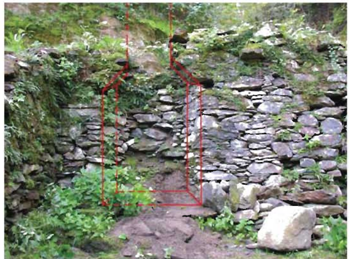
Facciata SUD: evidenziato il camino inserito nello spessore del muro
