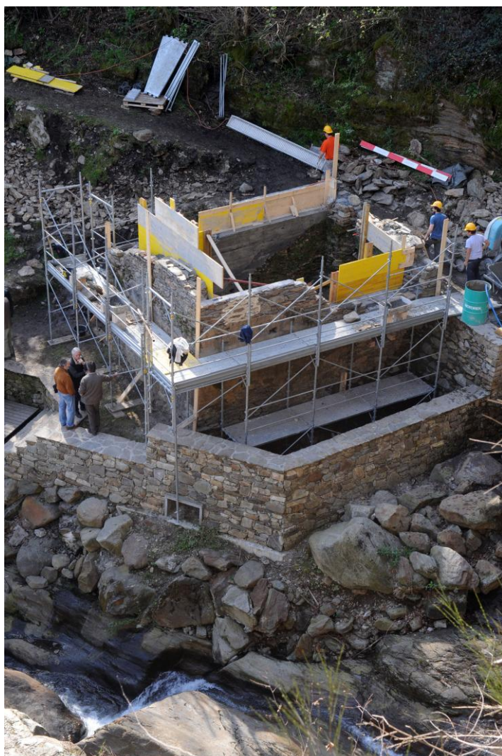
201 I: ricostruzione pareti perimetrali da parte di SSIC
