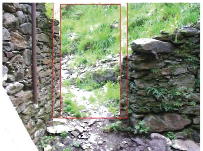
Facciata EST: evidenziato l'accesso all'edificio
