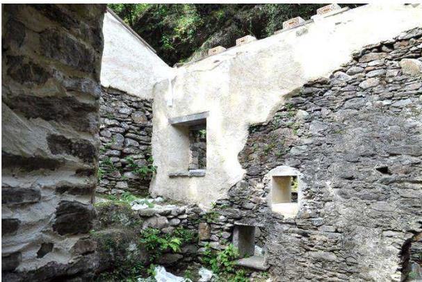
Abbildung 10: Die neu gebauten Mauerteile heben sich innen optisch von den historischen Resten ab.
