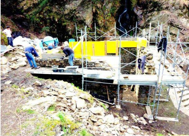
Abbildung 8: Die Mauern des Mühlegebäudes werden wieder aufgebaut.
