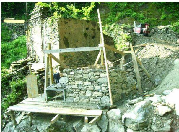
Abbildung 6: Bau der Hochwasserschutzmauern.
