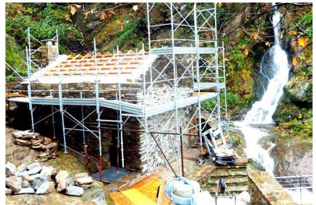
Abbildung 11: Der Dachstuhl wurde aufgebaut und kann mit Steinen gedeckt werden.
