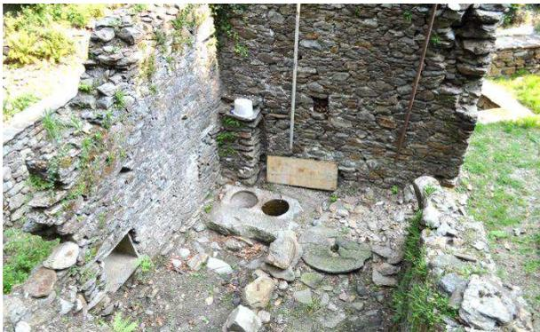
*Abbildung 13: Blick ins Inneren des Mühlegebäudes mit den beiden Becken der ehemaligen Stampfe in der Bildmitte.*
