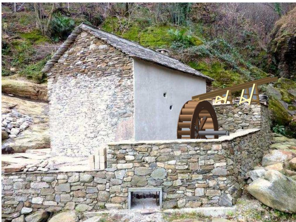
*Fotomontage von skizziertem Wasserrad mit Kanal auf fertig gestelltem Mühlegebäude.*
